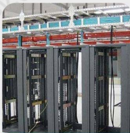
机房线路整理
