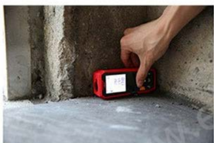
室内外装修设计及建筑施工
