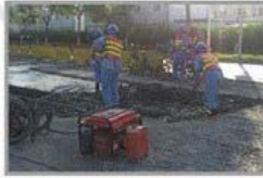
道路养护施工
