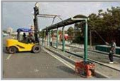
站台 市政施工
