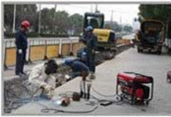
应急抢修施工
