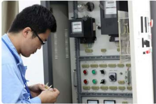
电力维修安装
