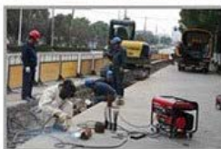
应急抢修施工
