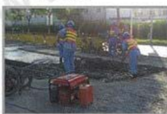
道路养护施工
