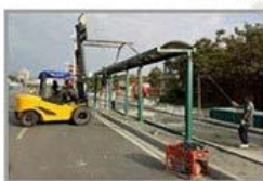
站台 市政施工
